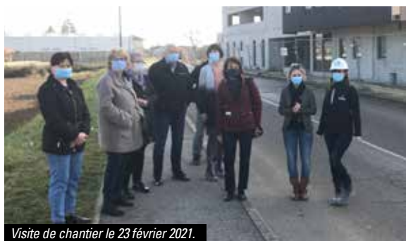
Visite de chantier le 23 février 2021.
